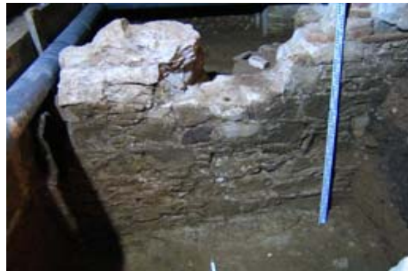
FOTO 4. Fonamentació de l'edifici UE 201
